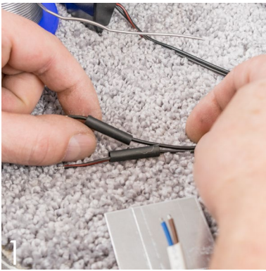
Schrumpfschlauch über die Kabel stülpen
