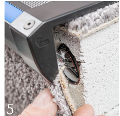
Beim Aufsetzen der Profile darauf achten, dass die Kabel nicht gequetscht werden.
